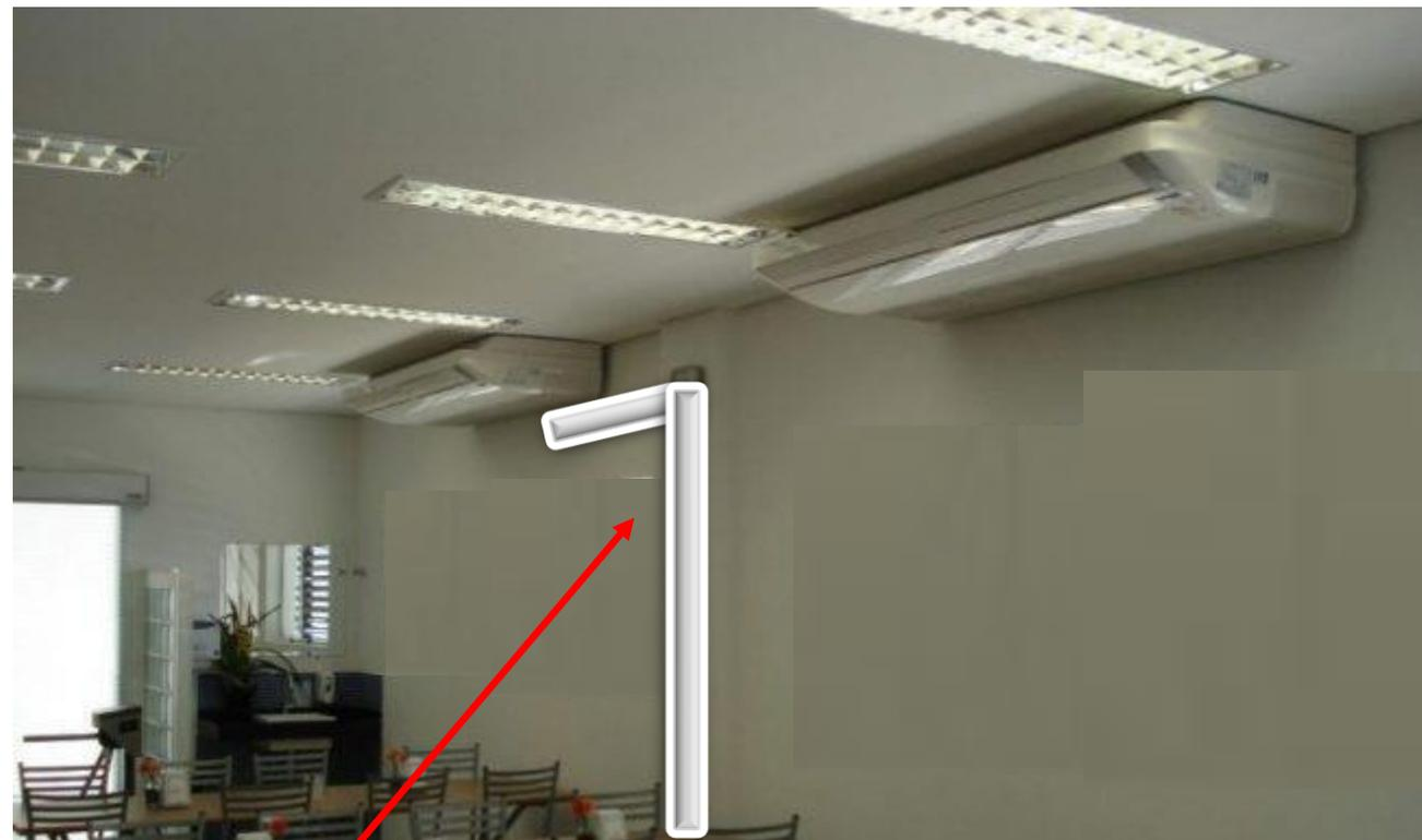
**Ilustração exemplificativa do conceito de instalação de acabamento com canaletas acomodando os tubos dos drenos.**
