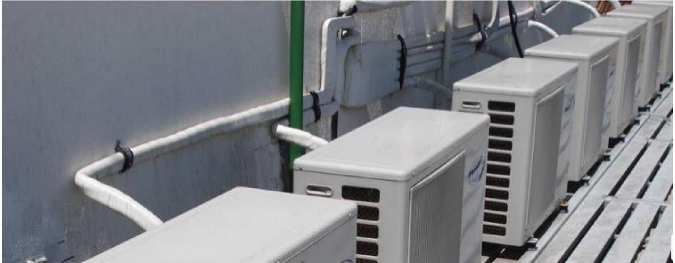
**\*NOTA:** Conforme a ABNT NRB 5410/2008 os cabos de força devem ter **seção mínima de 2,5mm<sup>2</sup>**. Então os cabos de interligação entre unidades deverão atender a Norma.
